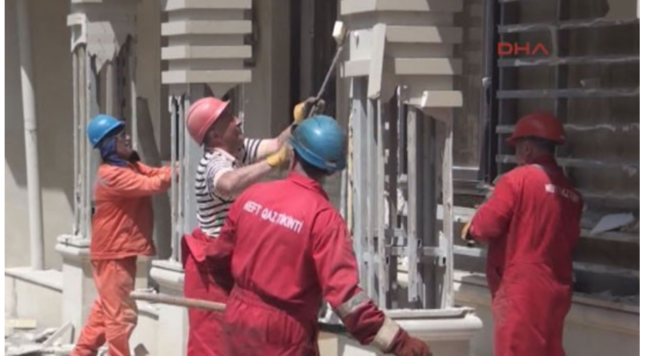
Bakü'de Yanıcı Diő Cephe Malzemeleri Sökülüyor 22/05/2015
