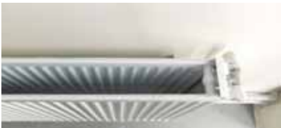
4.40 Toz Birikimine Karşı İçi Boşaltılmış Radyatör
