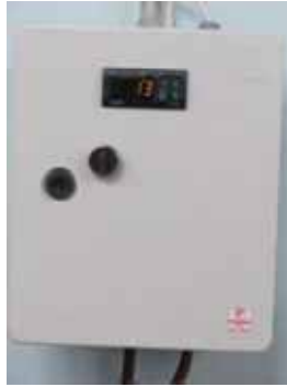
4.36 Otomatik sıcaklık termostatu (iyi örnek)
