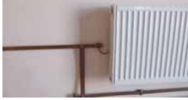
4.42 Statik Yük Topraklaması Topraklaması Yapılmış Radyatör
