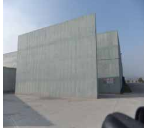
4.2 Beton Sütreler ve Kamera Kontrol Sistemi
