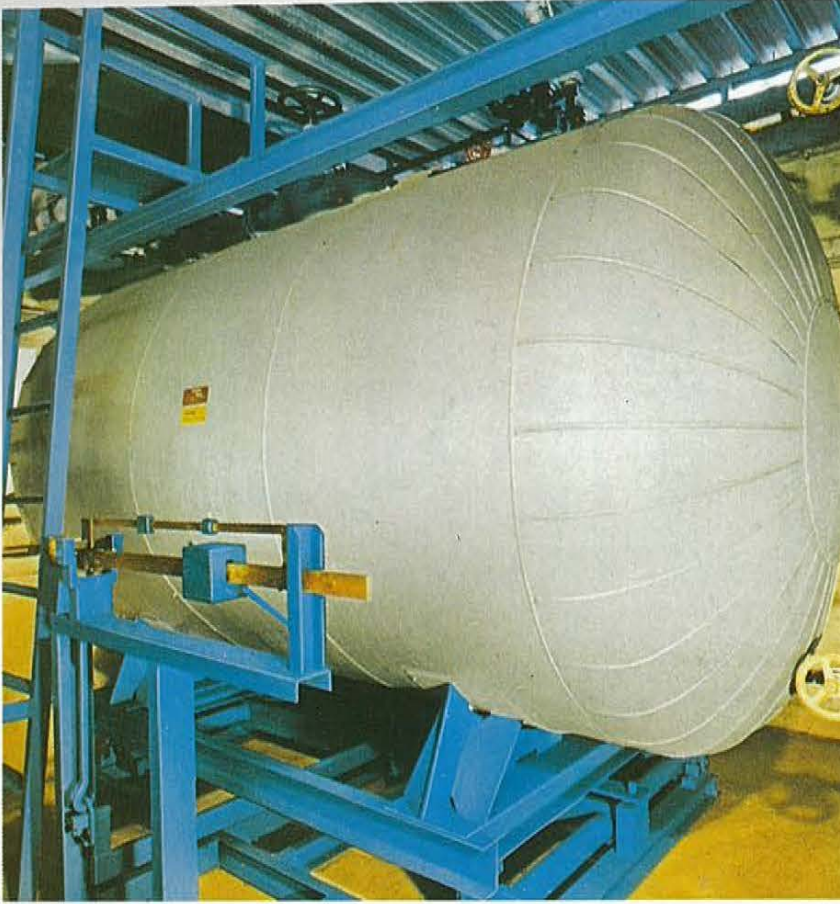
Şekil 3. Alçak basınç tankı. 2000 kg. ve daha yüksek değerler için daha ekonomiktir.
