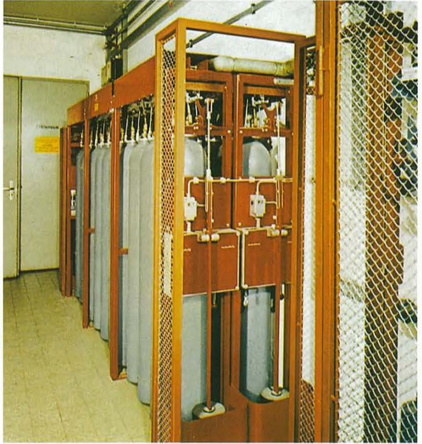
Şekil 2. Yüksek basınç silindirleri 250 bar test basıncında olmalıdır.
